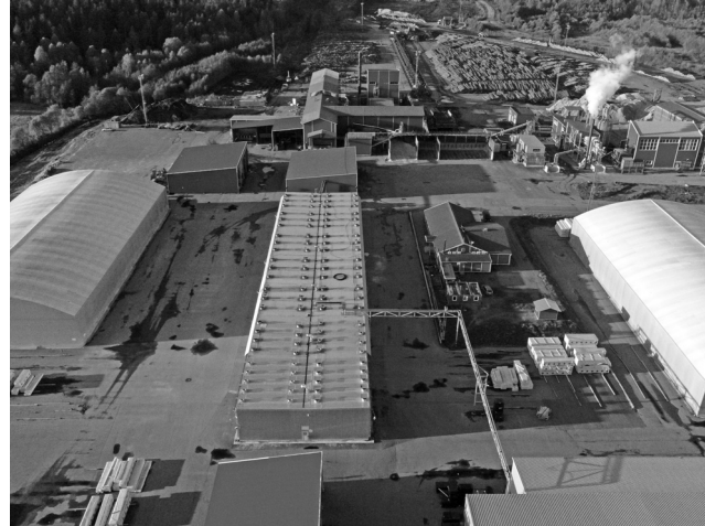
На производственной площадке «Сетлес»
